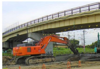
(d) 上空制限下での施工
