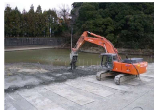
(e) 足場を確保しながらの泥土改良
