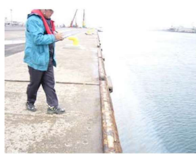
雷神埠頭地盤改良箇所
