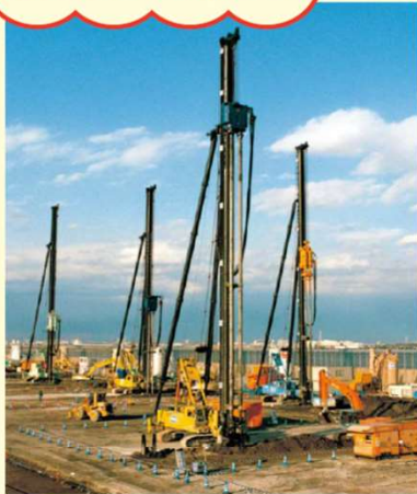
陸地での施工
