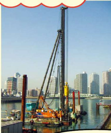
河川での施工
