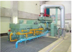
主原動機 (ディーゼルエンジン 846kw)
