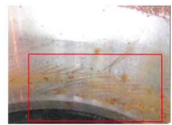
ケーシングライナ (羽根車先端とケーシングライナの接触痕)
