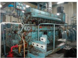
主原動機 (ディーゼルエンジン 308kw)
