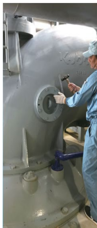
既存ポンプ設置点検窓
