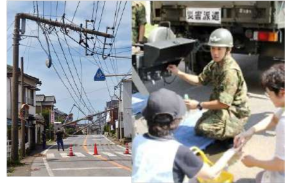
災害で折れ曲がった電柱（左）と自衛隊による給水（鋸南町）
