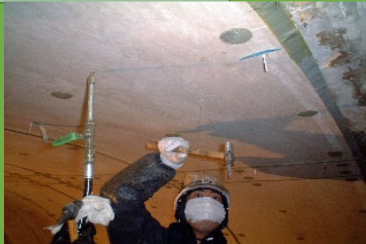
④ 充填材注入工・充填検査工
