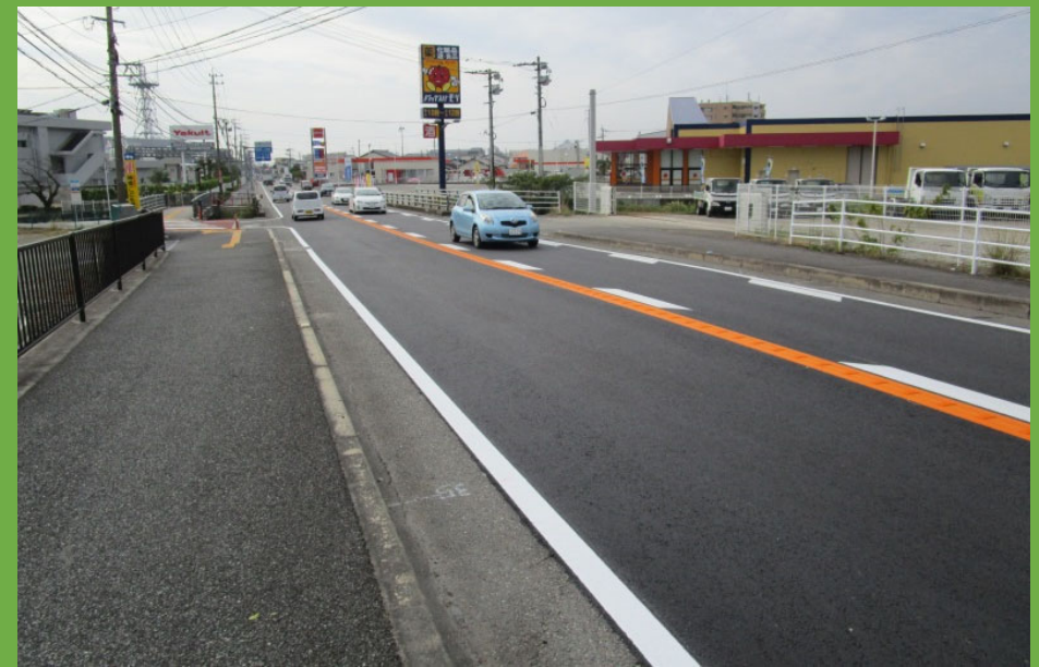
After (リラックスファルト舗装)
