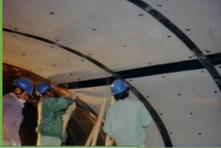
④ 充填材注入工・充填検査工
