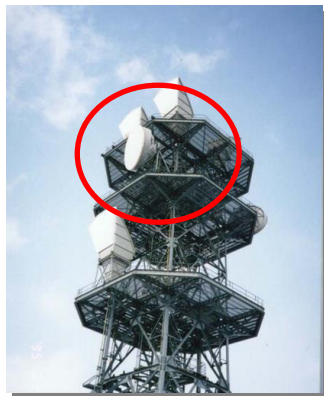
NTT無線中継鉄塔
