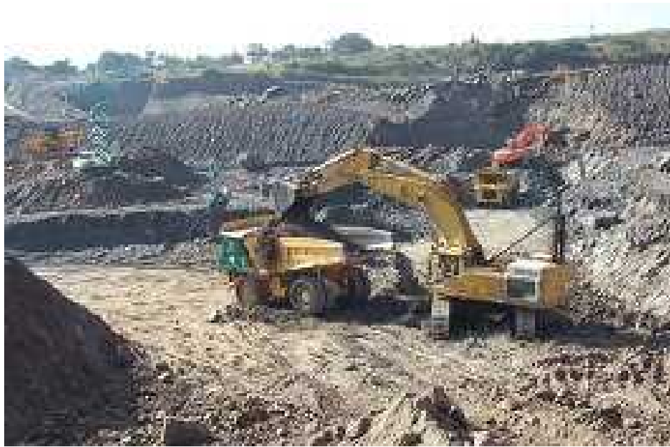
土工 (割岩、掘削、積込み)
