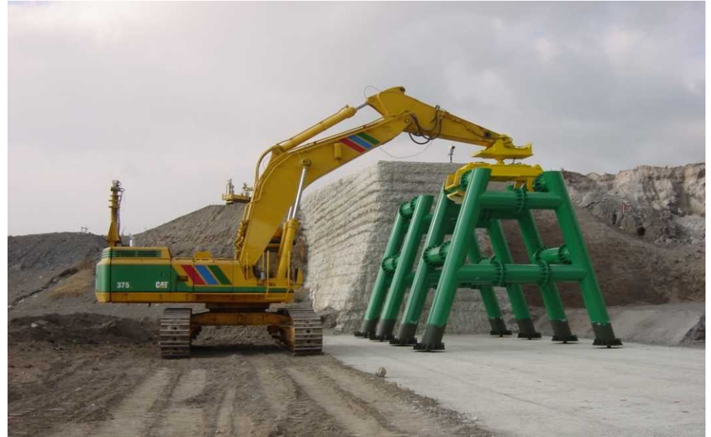
構造物設置工 (コンクリート打設、スリット設置)
