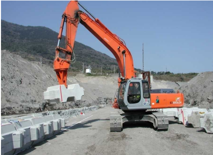
構造物設置工 (護床ブロック設置)
