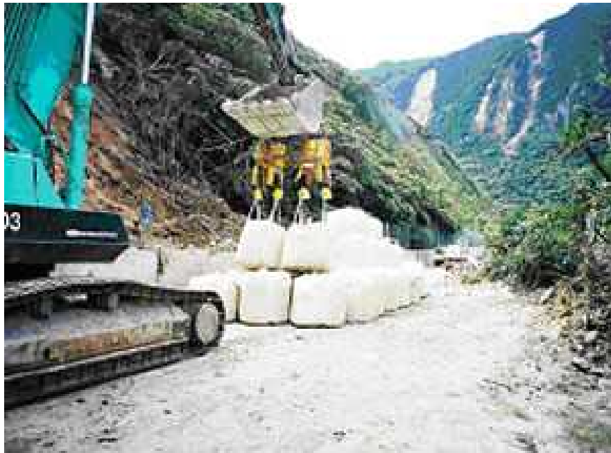
仮設工 (土嚢設置)
