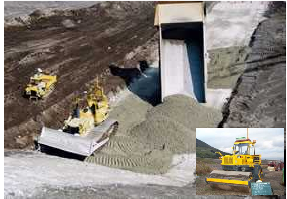
コンクリート工 (運搬、敷均し、締め固め)
