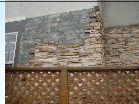
タイル自体が日射熱による変形を起こし接着剤とタイル面が剥離
