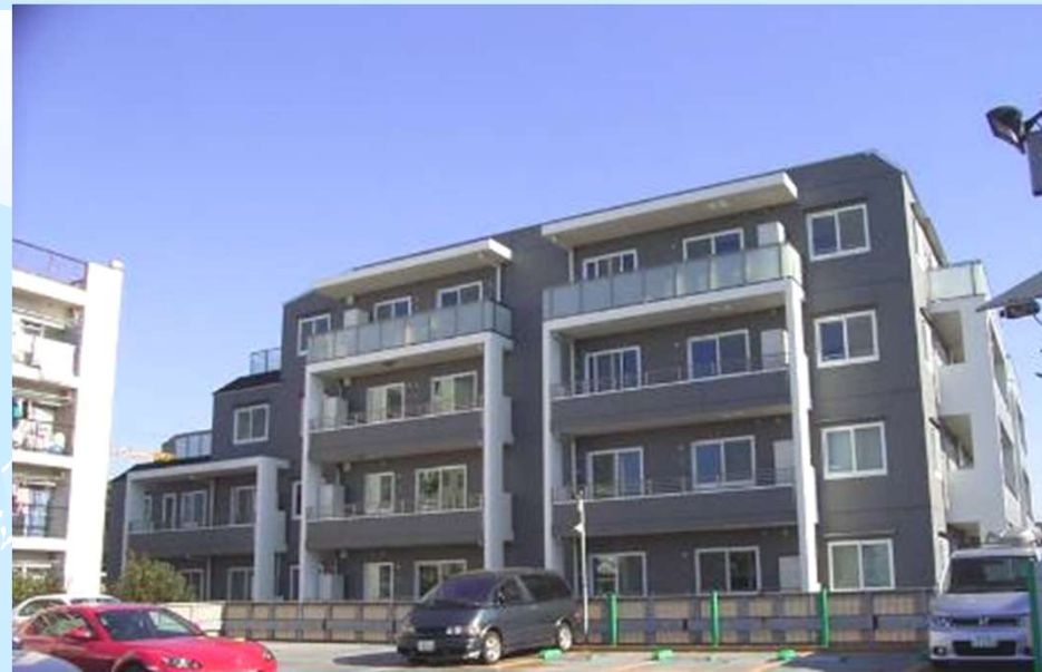
・大田区池上外断熱マンション
