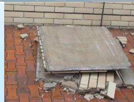
タイル自体が日射熱による変形を起こし接着剤とタイル面が剥離
