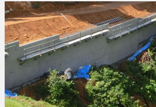
笠コンクリート前面足場
