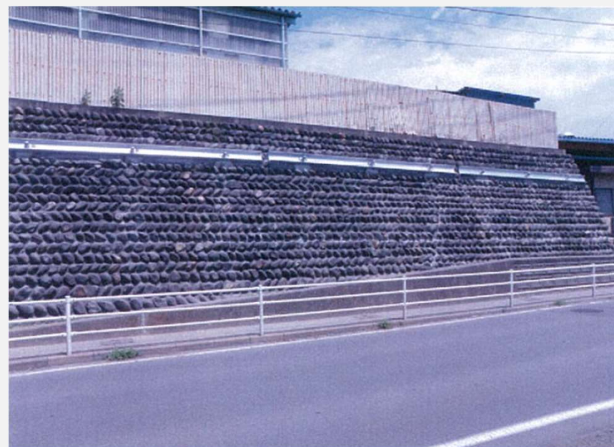
補強終了後擁壁状況
