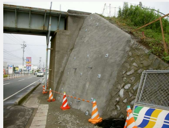
ミニアンカー打設後状
