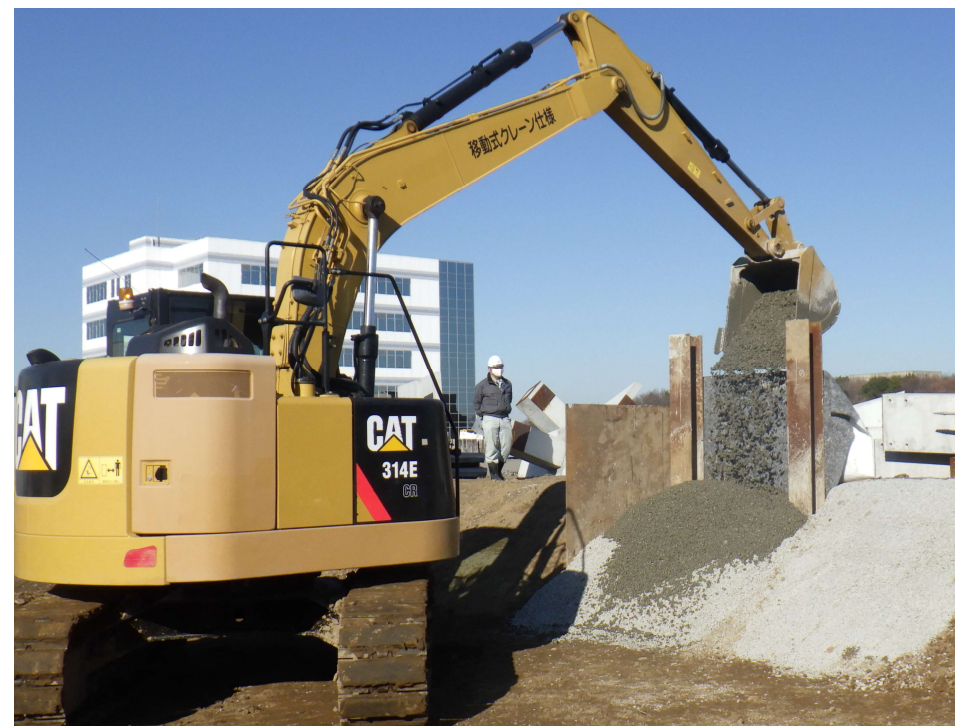
透水性改良造成状況
