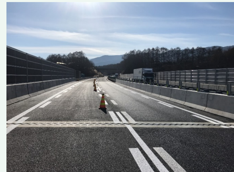
床版取替え完了
