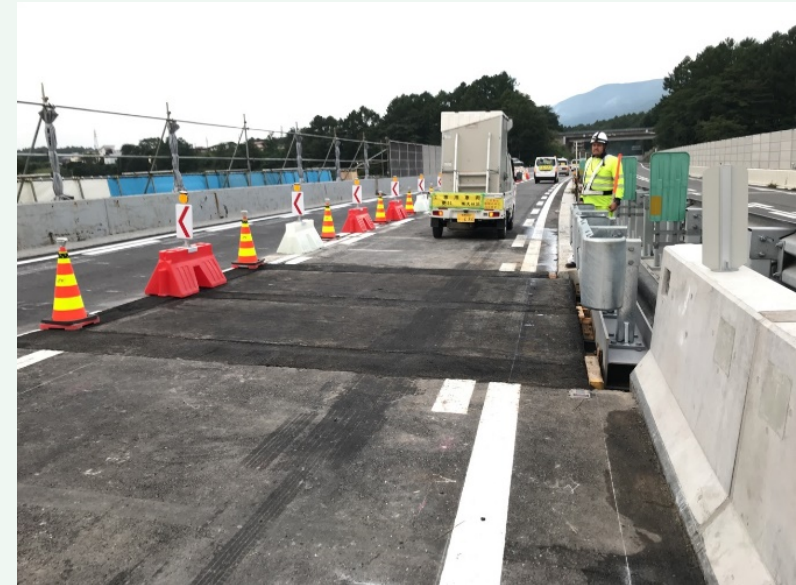
仮設床版設置～端部仮舗装
