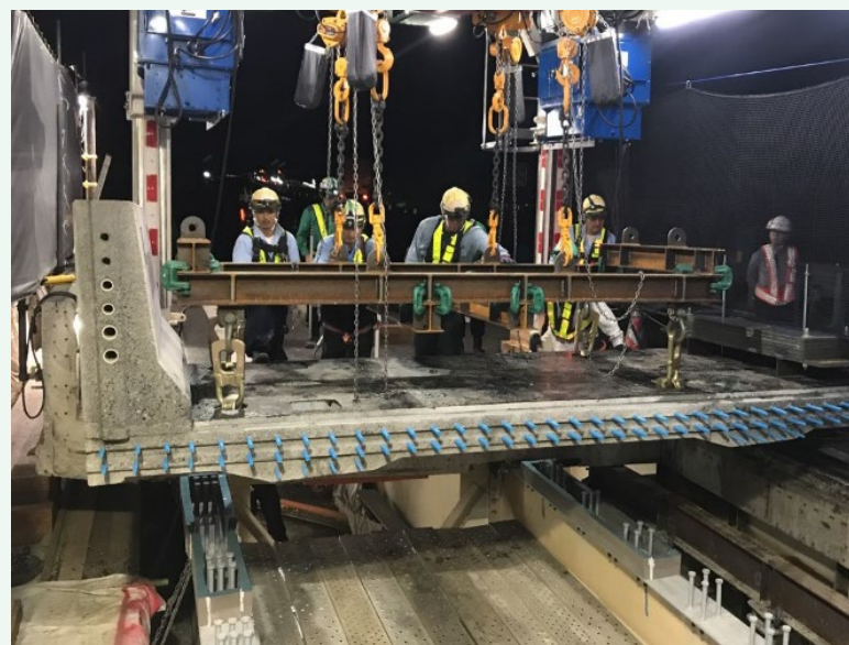
新設床版設置
