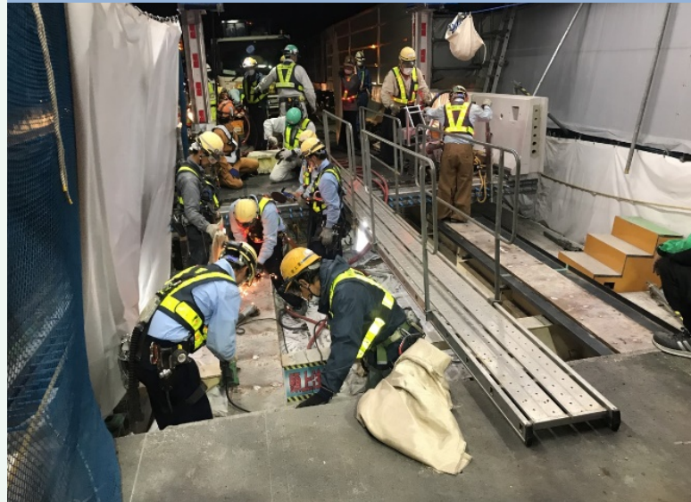
フランジ上面ケレン 既設スタッド切断
