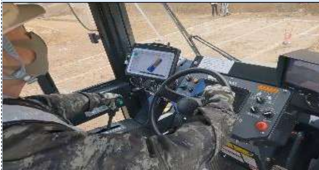
施工時リアルタイム管理状況 【αシステム】
