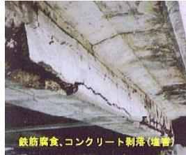
鉄筋腐食、コンクリート剥落(塩害)
