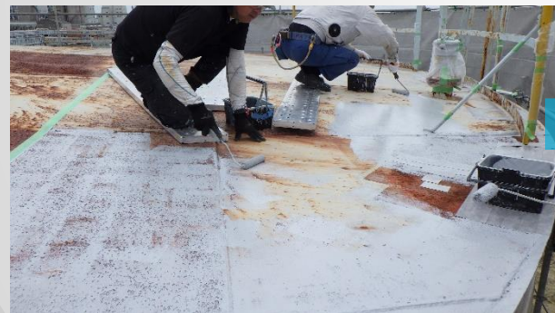
4. プライマー塗布
