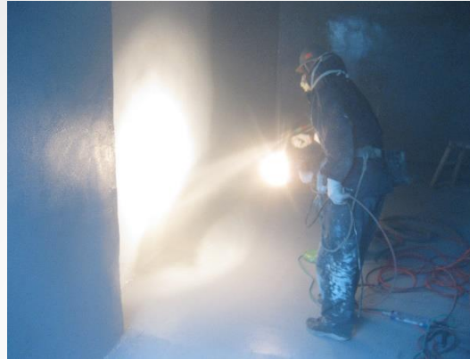
② 製鉄所 廃硫酸排水 コンクリートピット
