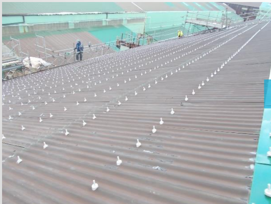
下地処理状況
