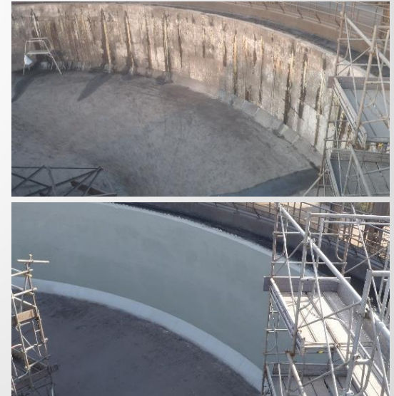
⑥ 製鉄所コンクリート貯水槽内面
