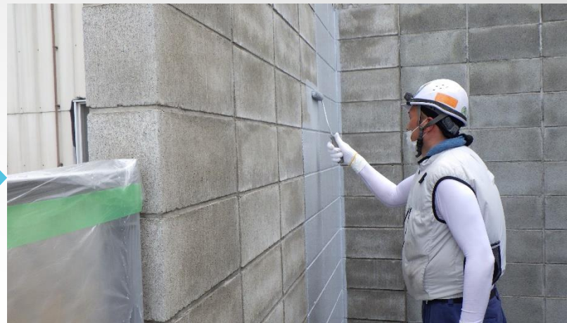
プライマー塗布状況
