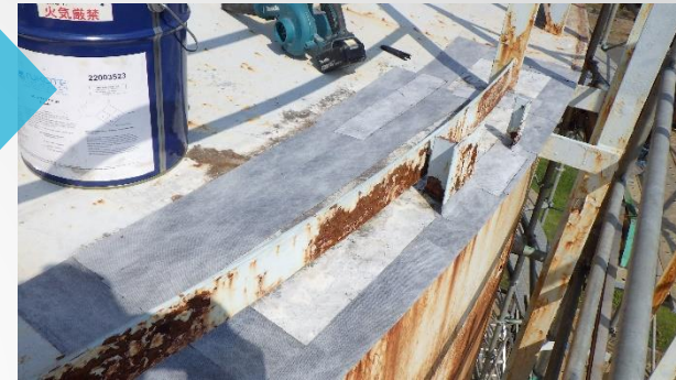
3. プチルテープ補修
