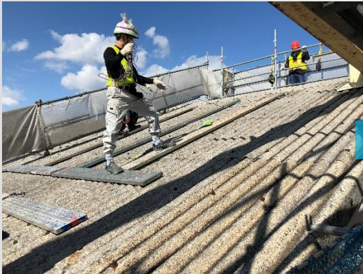
下地処理状況
