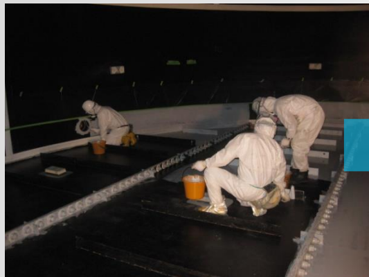
プライマー塗布
