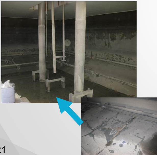
④ 発電所 温廃液ピット FRPライニング⇒ポリウレア
