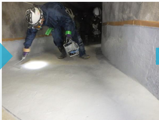
プライマー塗布状況
