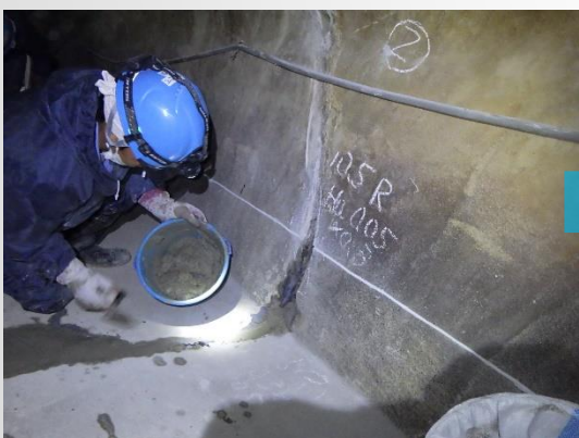
下地処理状況
