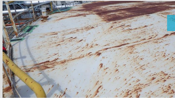
1. 金属タンク天井面状況
