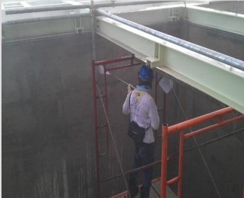
④ 発電所 温廃液ピット FRPライニング⇒ポリウレア
