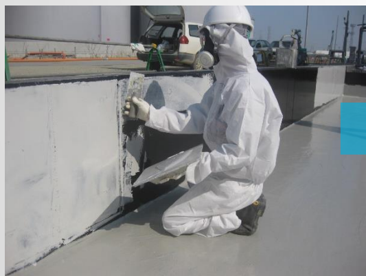
プライマー塗布
