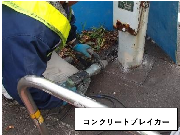
掘削及び目視
