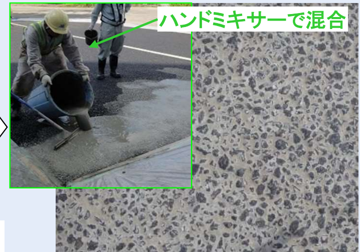
浸透用セメントミルクの製造
