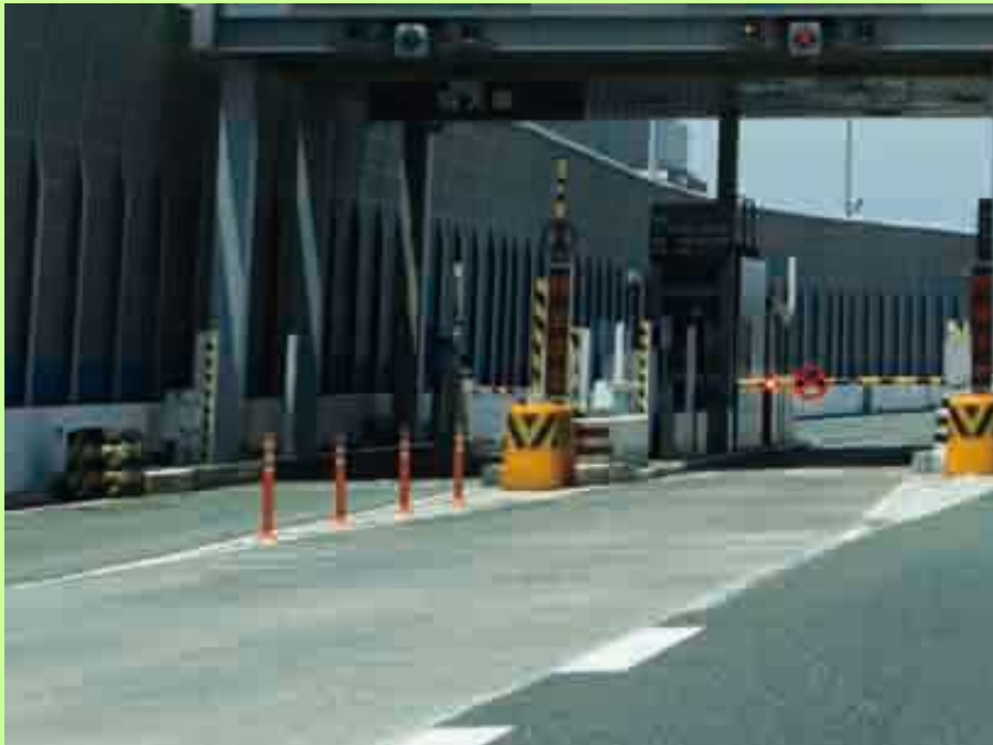
半たわみ性舗装(料金所)
