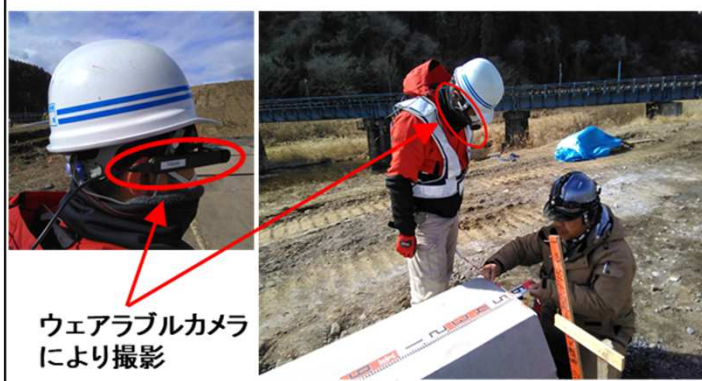
現場での受注者による撮影状況
