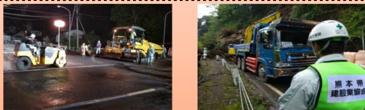
【通行不能の交差点での応急工事】(国道443号寺迫(益城町)) 【道路啓開(倒木、崩壊土砂の撤去)】(県道45号阿蘇講公園菊池線)
