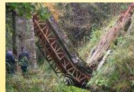
香川・徳島県境無名橋(鋼2径間単純トラス橋)の落橋(2007年)
