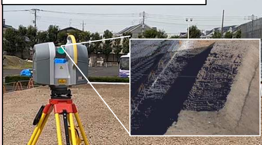
レーザースキャナ等の測量実習
