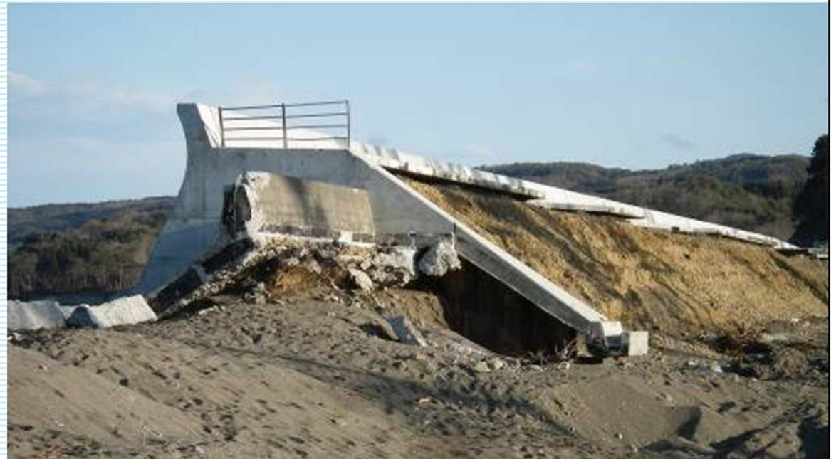
越流によって堤体が裏法面から崩壊する被害が発生してきた。
