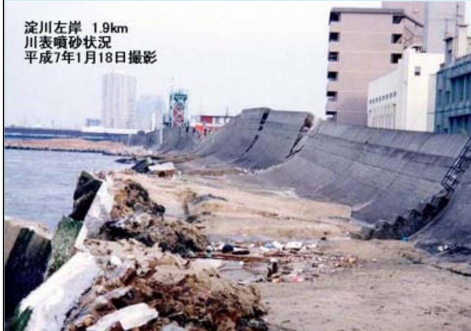
地震動によって堤体が大きく沈下する被害が発生してきた。
