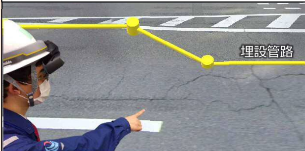
維持管理での3Dデータ活用(現場MR)実習
