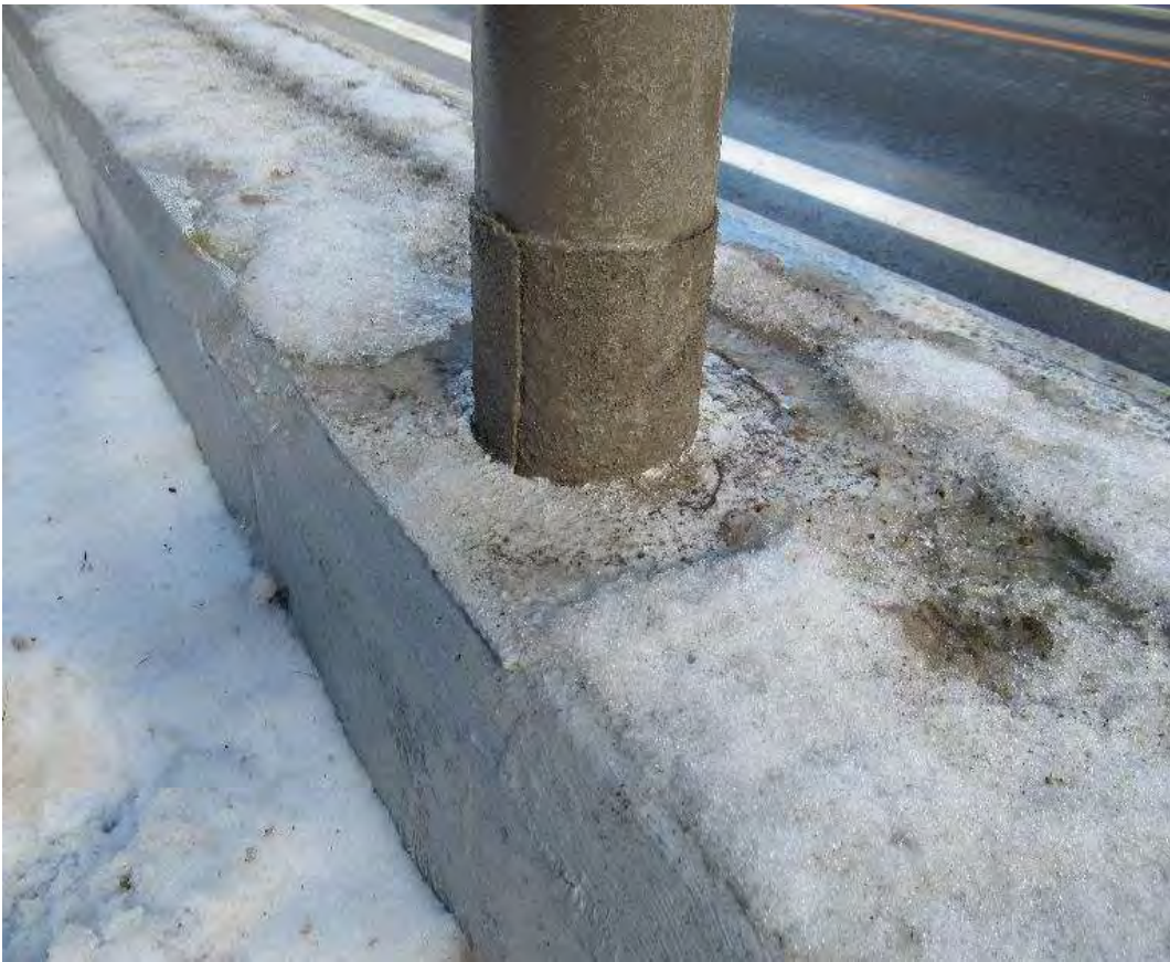
長野県 国道 防護柵 2020年施工
