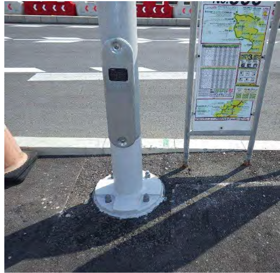
NEac + Q-set施工完了
