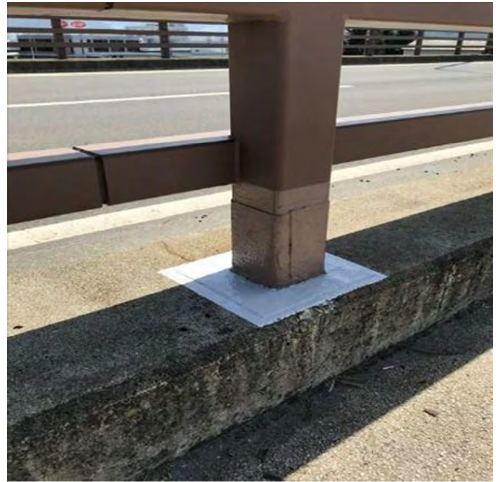
NEac + Q-set施工完了
