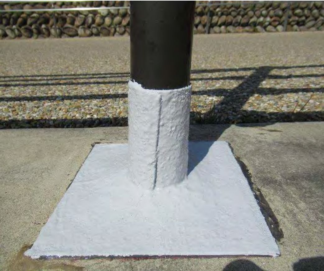
山梨県 某公園 防護柵 2021年施工
