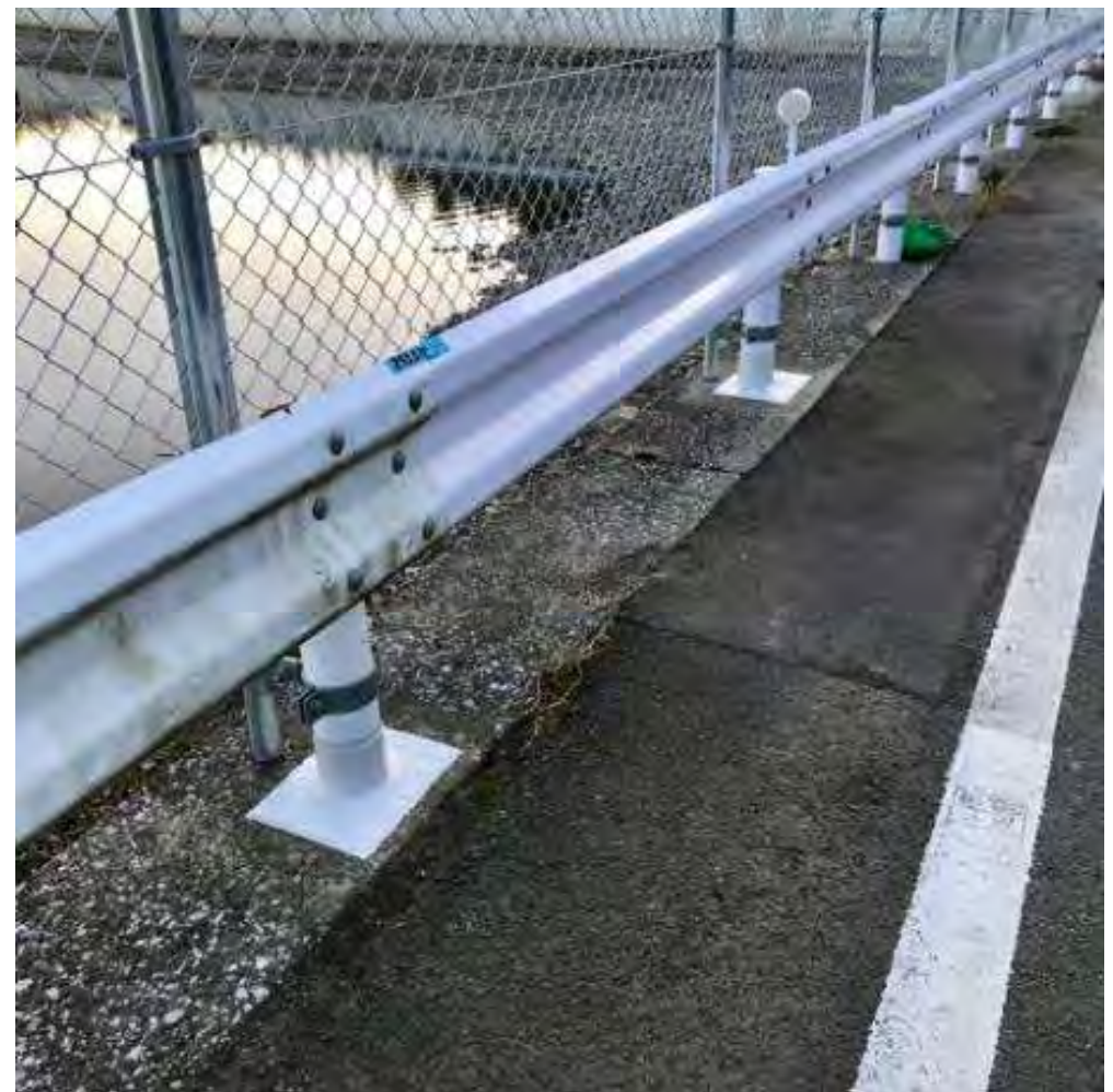
宮崎県 ガードレール支柱 2018年施工
