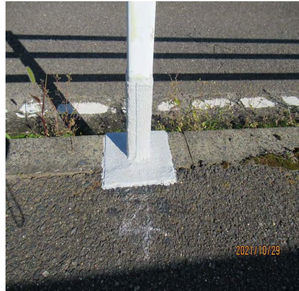
NEac + Q-set施工完了
