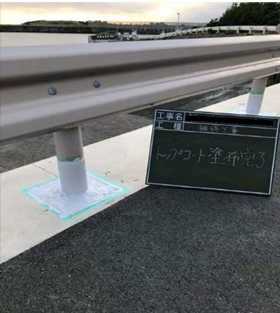
静岡県 漁港 ガードレール支柱 2019年施工
