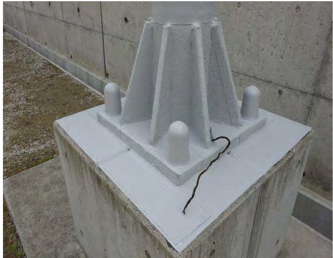
奈良県 鉄道 鋼管基脚部 2019年施工
