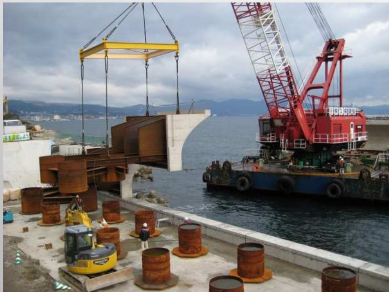
ブロック据付状況
