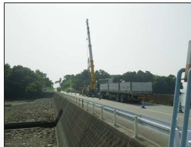
ブロック搬入状況
