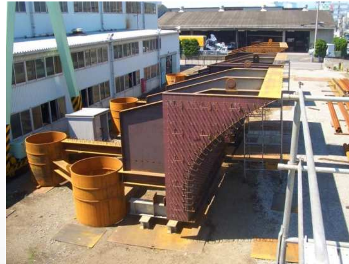
ブロック製作状況
