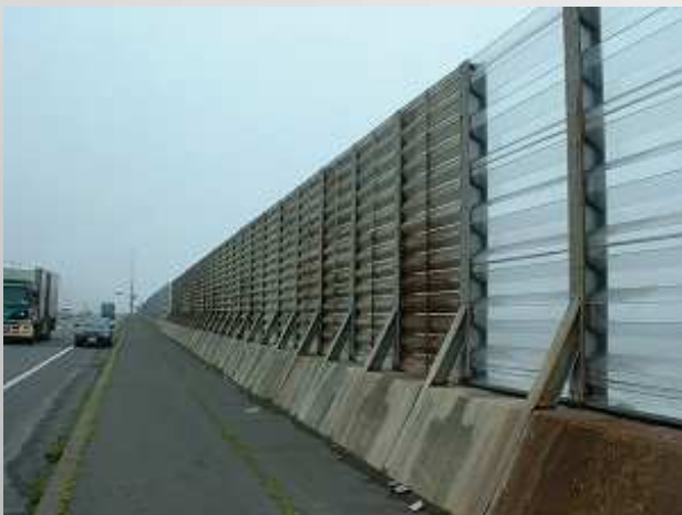
④鋼製越波防止柵 (眺望阻害)
