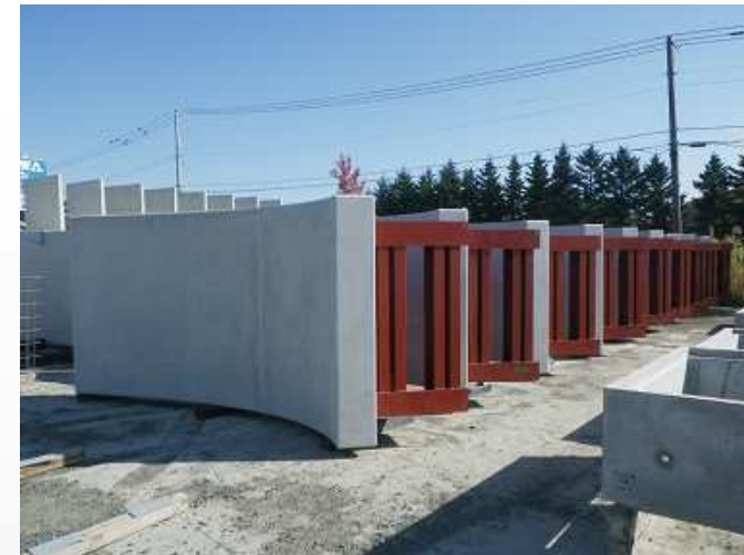
ブロック完成状況
