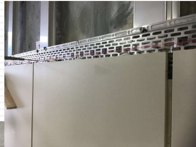
▲不陸の調整胴縁上ビームホール工法にて600mm角タイル
