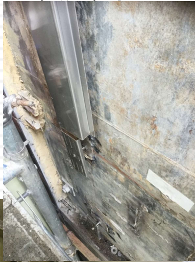
▲不陸の調整胴縁上ビームホール工法にて600mm角タイル
