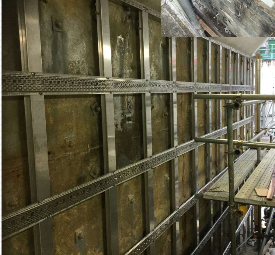
▲不陸の調整胴縁上ビームホール工法にて600mm角タイル
