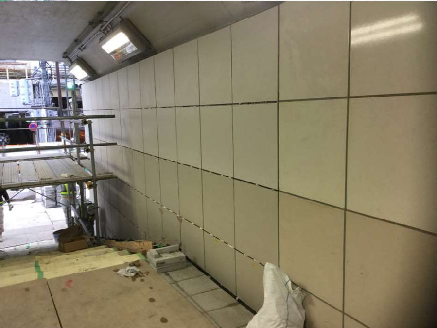
▲不陸の調整胴縁上ビームホール工法にて600mm角タイル
