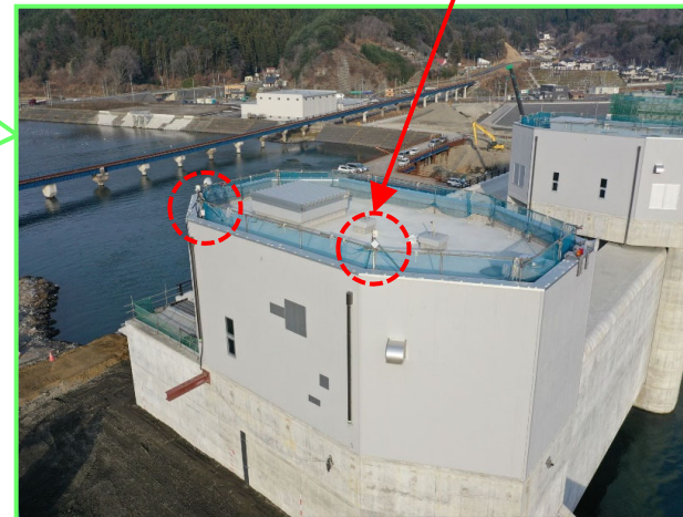
堰柱の屋上 (カメラ高さT.P. + 24m)
