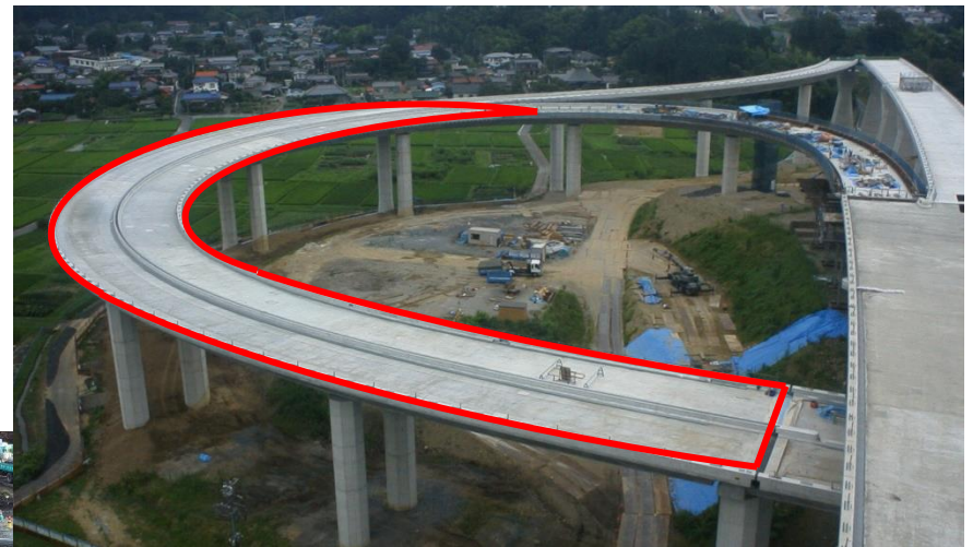
道路橋上部工(ランプ橋)
