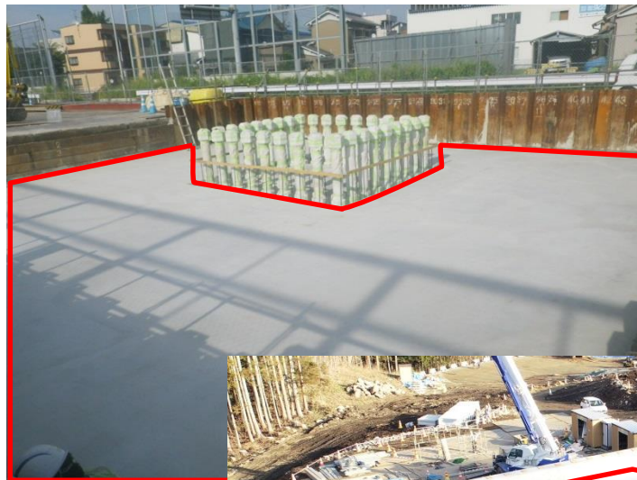
道路橋下部工(フーチング)
