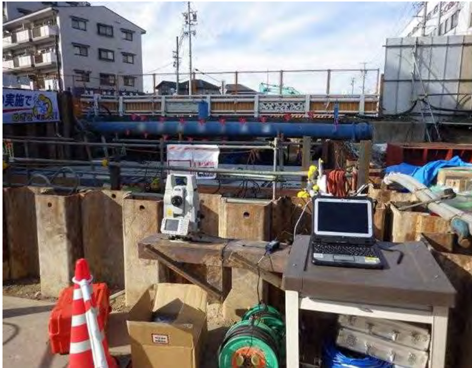
トータルステーション設置状況
