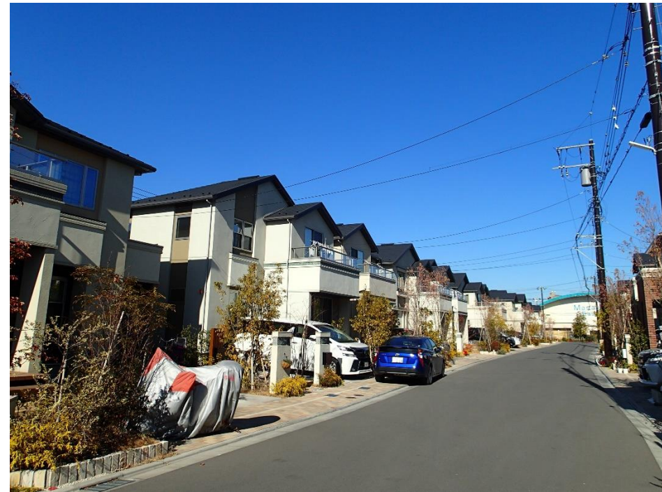
完成後の状況
