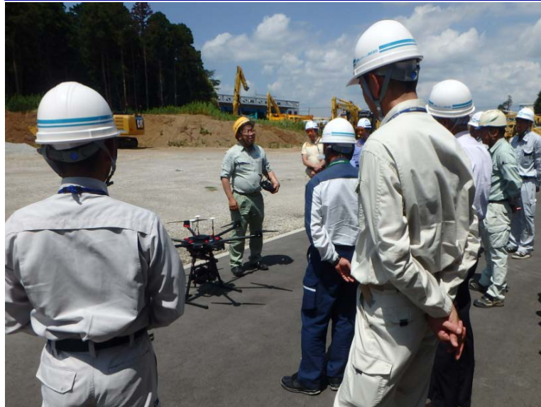
UAVを用いた起工測量((株)西尾レントオール)
