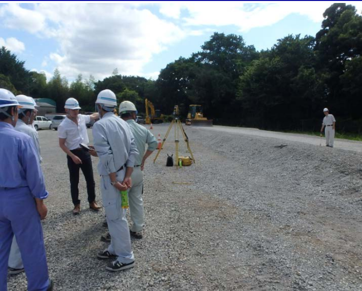
TS・LSを用いた出来形確認((株)トプコンソキアポジショニングジャパン)
