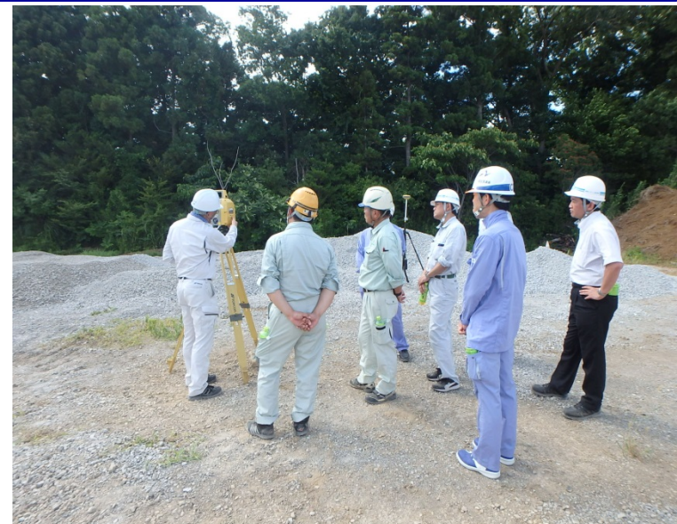
TS・LSを用いた出来形確認((株)トプコンソキアポジショニングジャパン)
