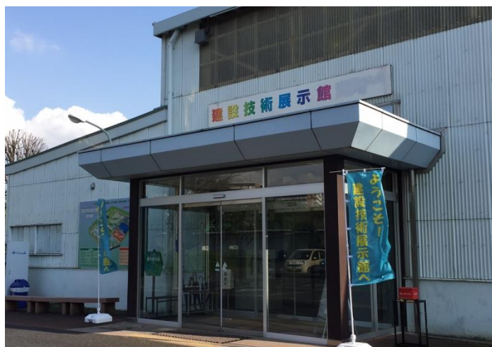
建設技術展示館
