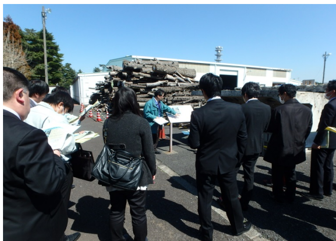
50年経過した床版劣化サンプル
