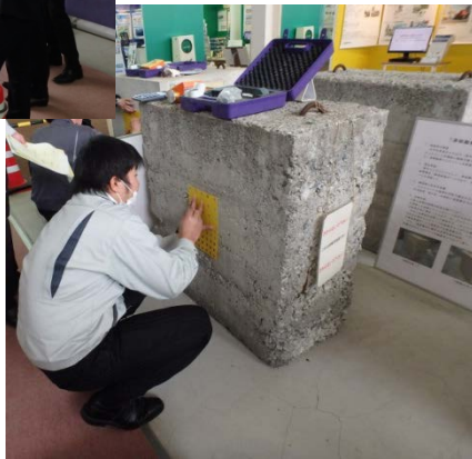
不良コンクリート
