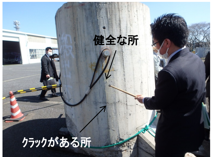
テストハンマーによる打音検査
