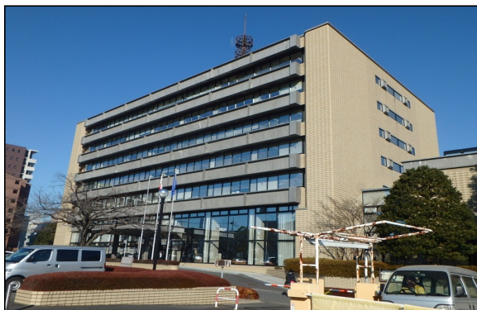
水戸合同庁舎（茨城県水戸市）
