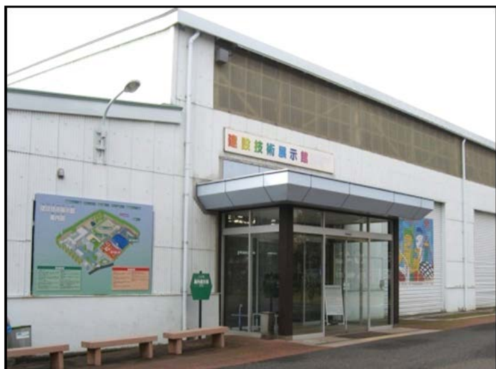
建設技術展示館
