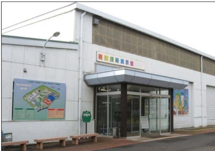
建設技術展示館
