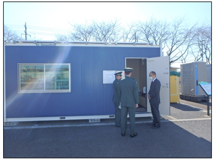
現場仮設ソーラーシステムハウス (株ダイワテック)
