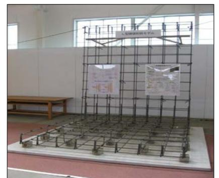
鉄筋組み立てモデル
