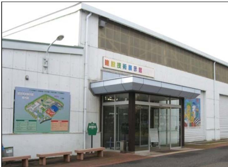
建設技術展示館
