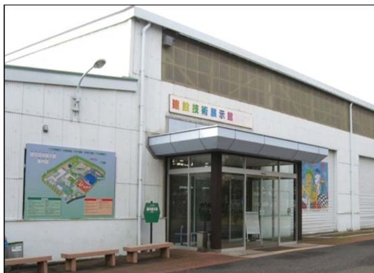
建設技術展示館
