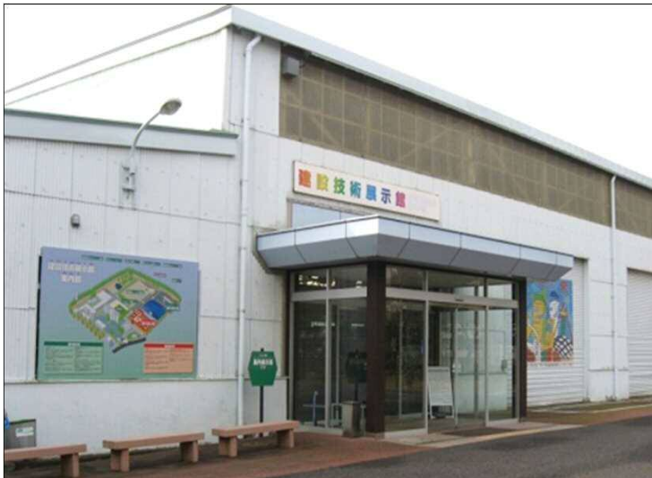
建設技術展示館
