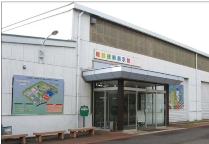
建設技術展示館
